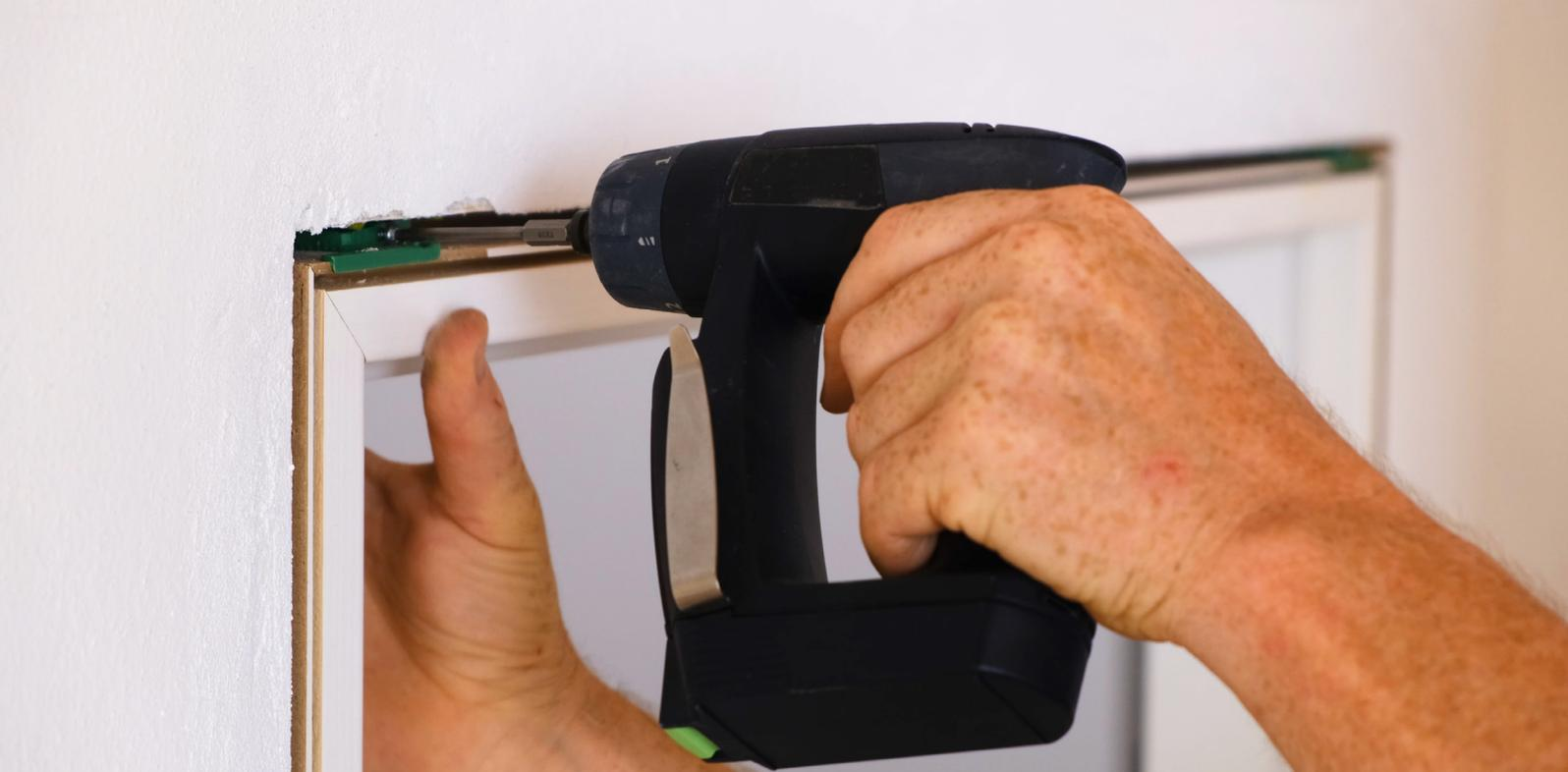
2 **BLOCCO MECCANICO DEL TELAIO**
